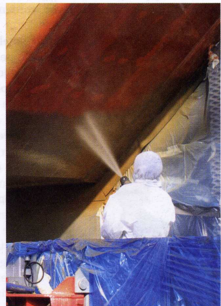
Hotspray systemen zijn heel eenvoudig op verticale vlakken aan te brengen.
