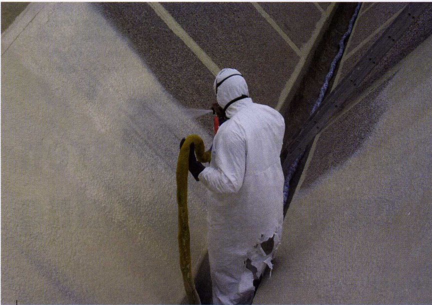
Hotsprays zijn warm verspoten coatings met een zeer snelle droogtijd van 3 tot 5 seconden.
